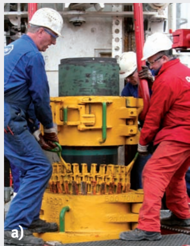
v.l.n.r.: a) Rohreinbau zur Sicherung der Bohrung; b) Einbau eines so genannten Y-Tools, das Bohrlochmessungen während der Thermalwasserproduktion ermöglicht; c) Thermophysikalische Fluidmessungen im Labor
